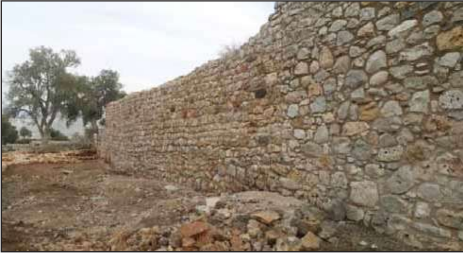
Resim 9: Sur duvarı konservasyon.
