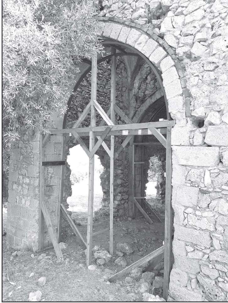
Resim 5: Yelli Camii' de yapılan geçici onarım uygulamalarından bir örnek.
