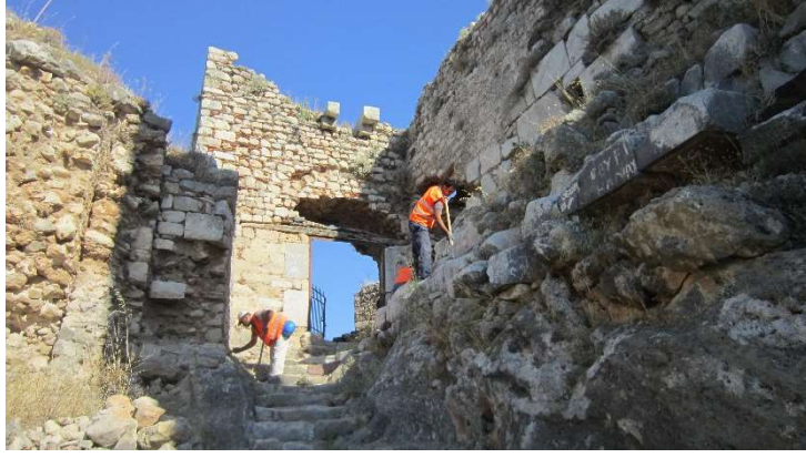
Foto. 1: Temizlik Çalışmaları (İç Kale Merdivenleri)
