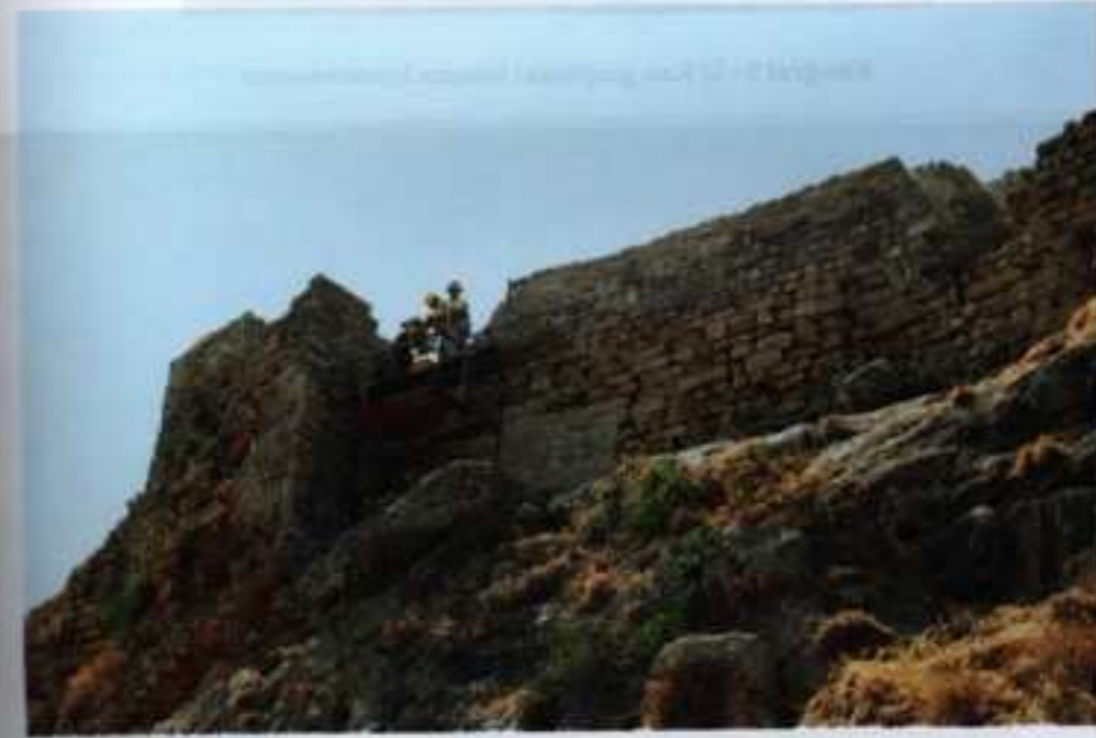
Fotoğraf 4 - İç Kale doğu surlarının konservasyonu
