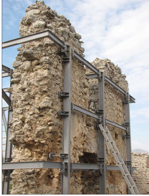
Resim 3: Yelli Medrese duvarların elik konstrüksiyonlarla desteklenmesi.
