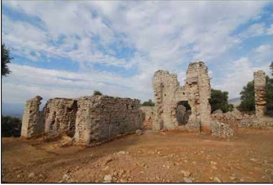
Resim 7: Yelli Medresesi- Güneybatı cepheden görünüm
